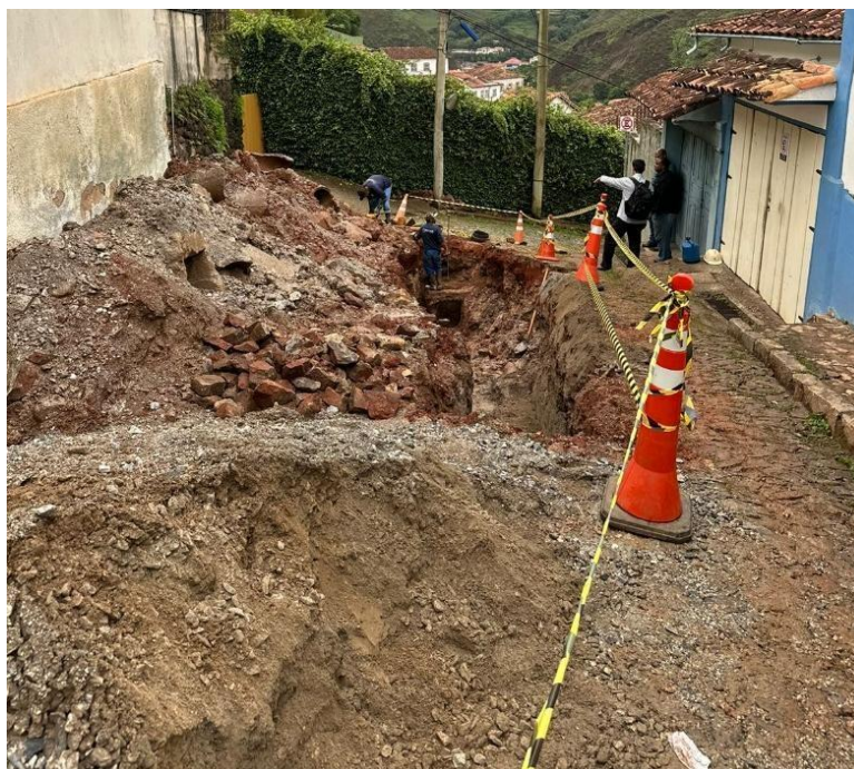
Figura 15: Manutenção da rede de drenagem e reconstituição do calçamento
