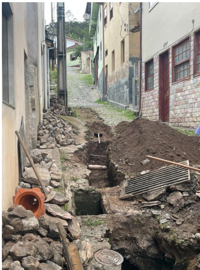
Figura 11: Manutenção da rede de drenagem e reconstituição do calçamento
