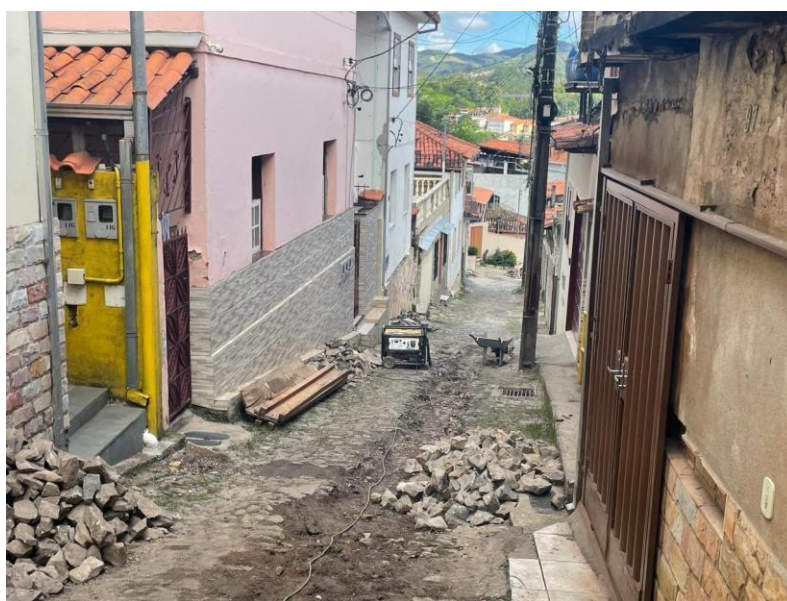
Figura 12: Manutenção da rede de drenagem e reconstituição do calçamento
