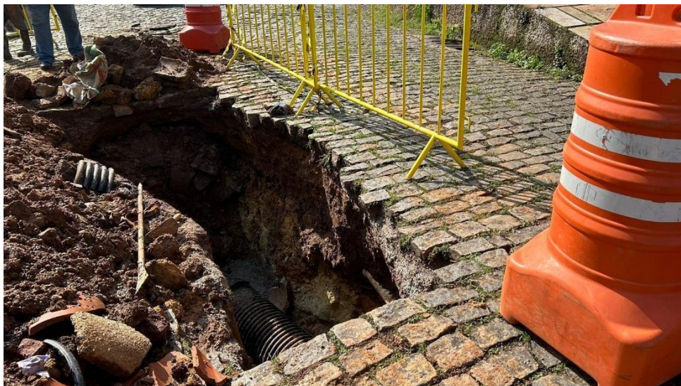
Figura 13: Manutenção da rede de drenagem e reconstituição do calçamento
